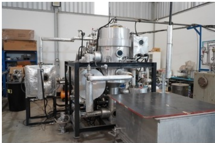
サンアップが基礎実験で用いたプラントの一部＝5月、チョンブリ県（NNA撮影）
